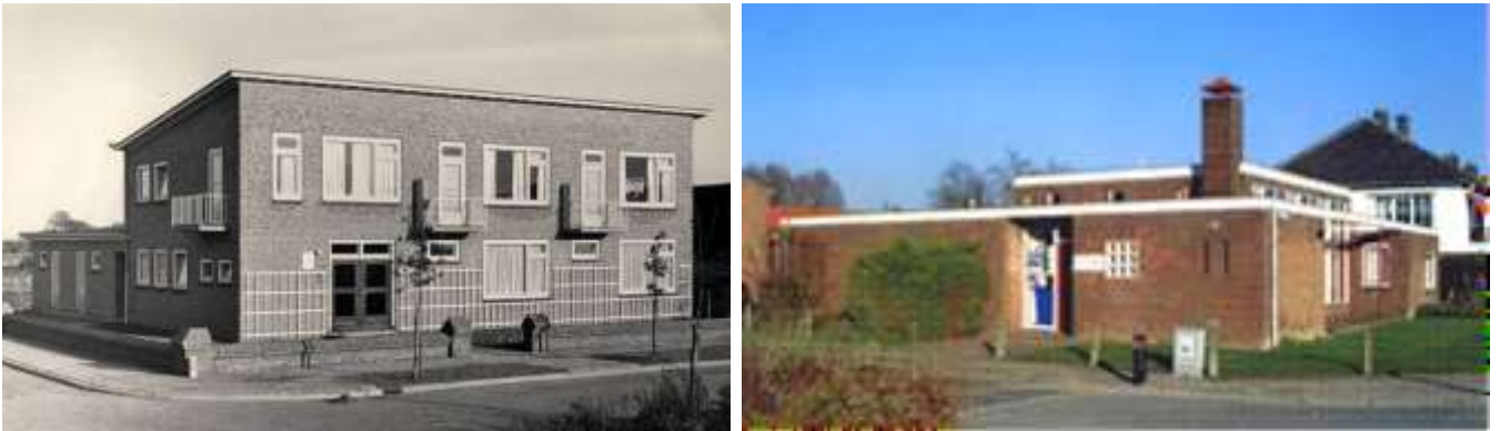
Gele Kruisgebouw te Wijchen, ca. 1955 (foto collectie F. Coolen, Wijchen) en gebouw van het Wit-Gele Kruis in Sluiskil (foto: Merwijk. T. van).
