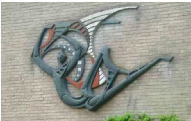
Detail schoolgebouw De Leer met wandreliëf in Hengelo.
