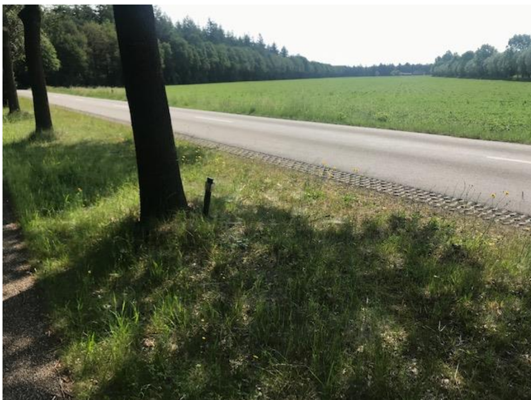
Afbeelding 27: Kansen voor verschrallingsbeheer Ruurlose/Bleuminkmaatweg waar op diverse plekken al redelijk schrale omstandigheden aanwezig zijn met soorten als havikskruid, gewoon biggenkruid, margriet, ooievaarsbek, duizendblad en smalle weegbree. Op deze plekken wordt reeds verschrallingsbeheer toegepast.
