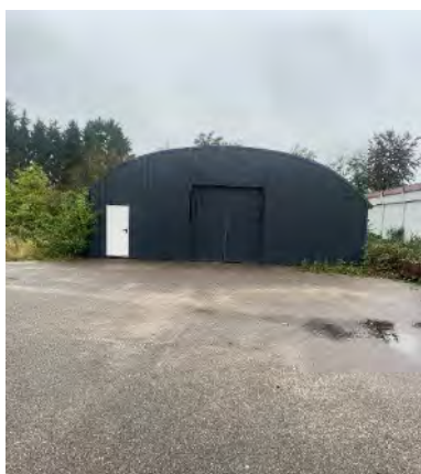
Achterste loods op het terrein
