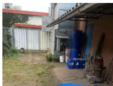
Buitenterrein, zuidzijde afzuiginstallatie en opslag onder afdak
