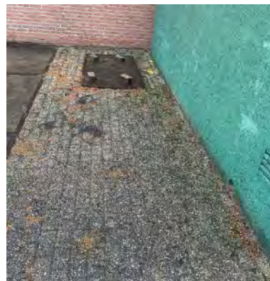
Naast de lakkluis, is een soort funderingsplaat aanwezig. Het is niet bekend wat hier heeft gestaan
