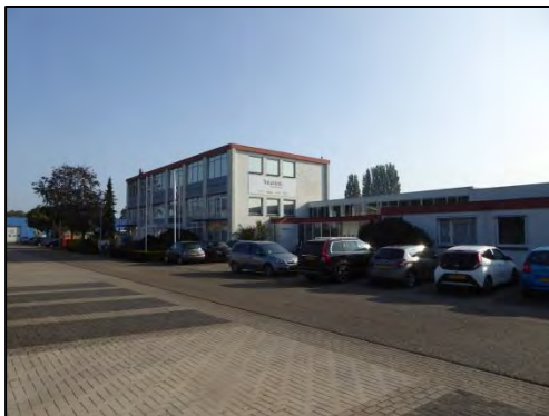
De loods opgetrokken uit metaal.
