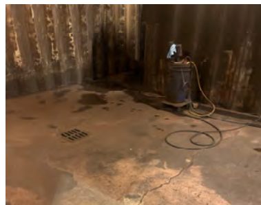
Naast (ten zuiden van) de spuitcabine is een 'wasplaats' aanwezig
