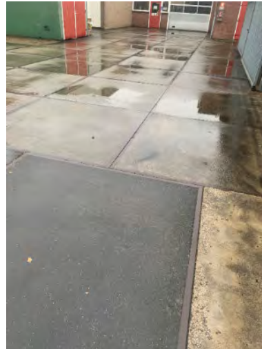
Buitenzijde vh pand (laad- en losgedeelte)
