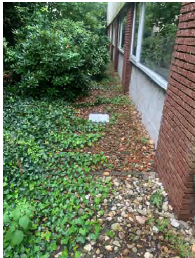
Ten noorden van het pand is een put aanwezig in de grond, mogelijk werd daar in het verleden het afvalwater van de zeefdruk geloosd op de riolering.
