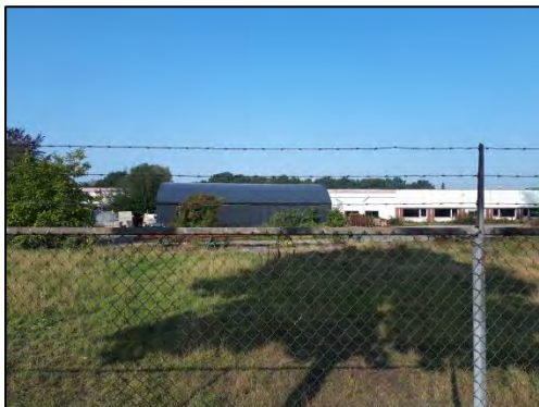
De loods opgetrokken uit metaal.
