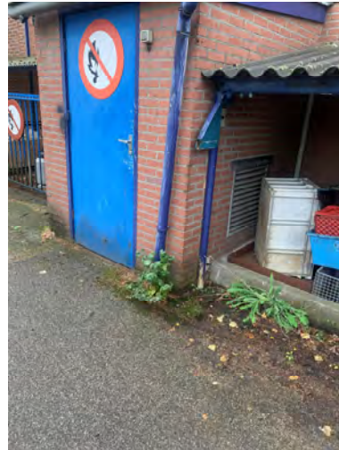
Aan de voorzijde van het middelste pand is de opslaglocatie onder een afdak boven een lekbak.
