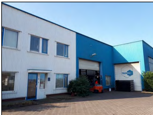
De loods foto genomen van de noordkant.
