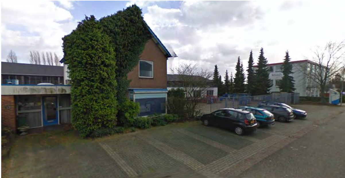
De verouderde bebouwing op het Industriepark (Bron: Google Streetview).
