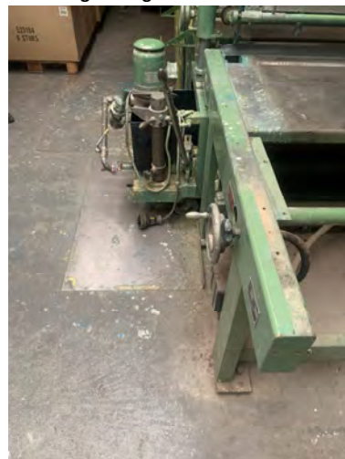
Op enkele plekken zijn de voormalige machines nog aanwezig:
