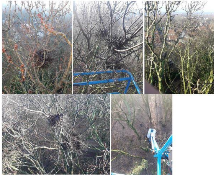
Foto's van werkzaamheden van de aannemer, Kerkstraat Gaanderen
