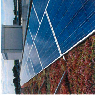
Figuur 33: Bruin vogeldak met zonnepanelen
