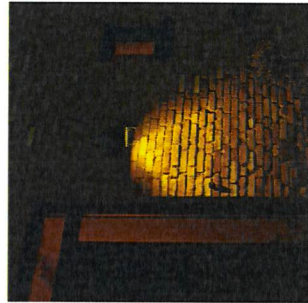
Figuur 40: Vleermuisvriendelijke verlichting aan gevel
