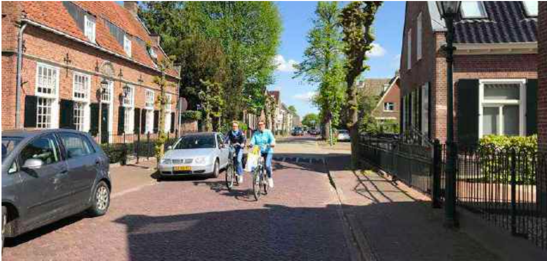
Ruimte is beperkt, rijbaan is 5,25 meter - auto en fiets gemengd - auto in twee richtingen - parkeren op straat - leilindes als slimme groene oplossing bij beperkte ruimte
