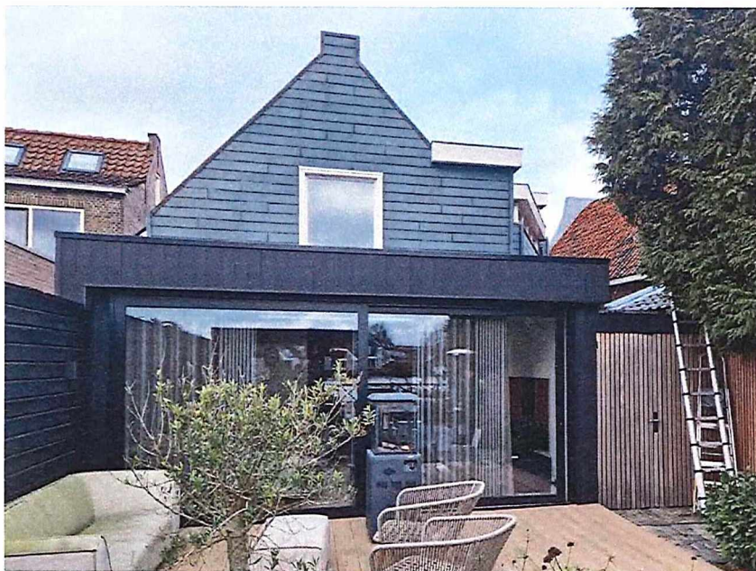
foto van na de vervanging van de serre, achtergevel
