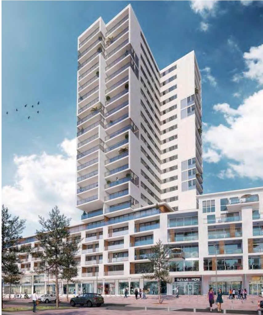
Voorbeeld van hoogbouw met publieke plint en op een onderbouw, Nesselande Rotterdam
