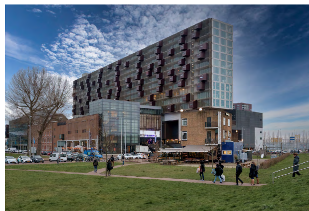
Schiecentrale Rotterdam, bergingen aan de galerij, Mei Architects © Frits de Wolf Fotografie
