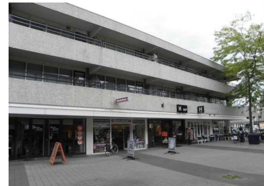
Projectmatige bouw: herhaling en ritmiek
