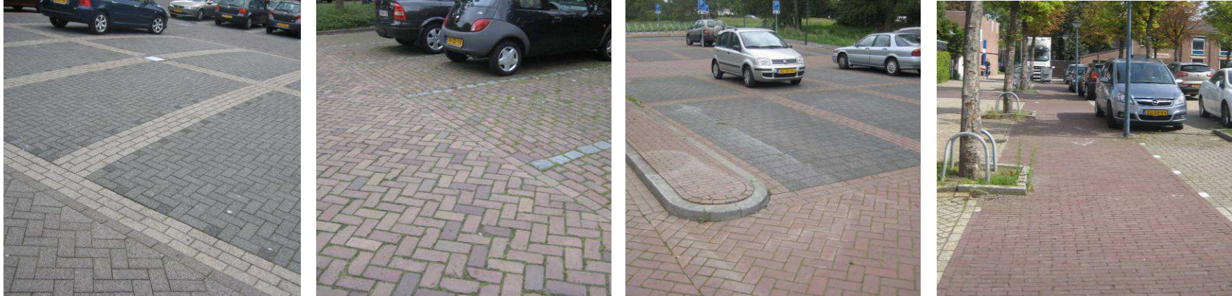
Divers kleur- en materiaalgebruik parkeerterreinen
