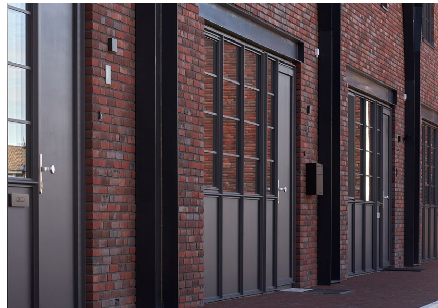
Figuur 25: Afwisseling van staal, glas en baksteen
