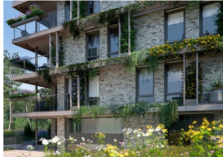
Figuur 15: Balkons als integraal onderdeel van het gebouw
