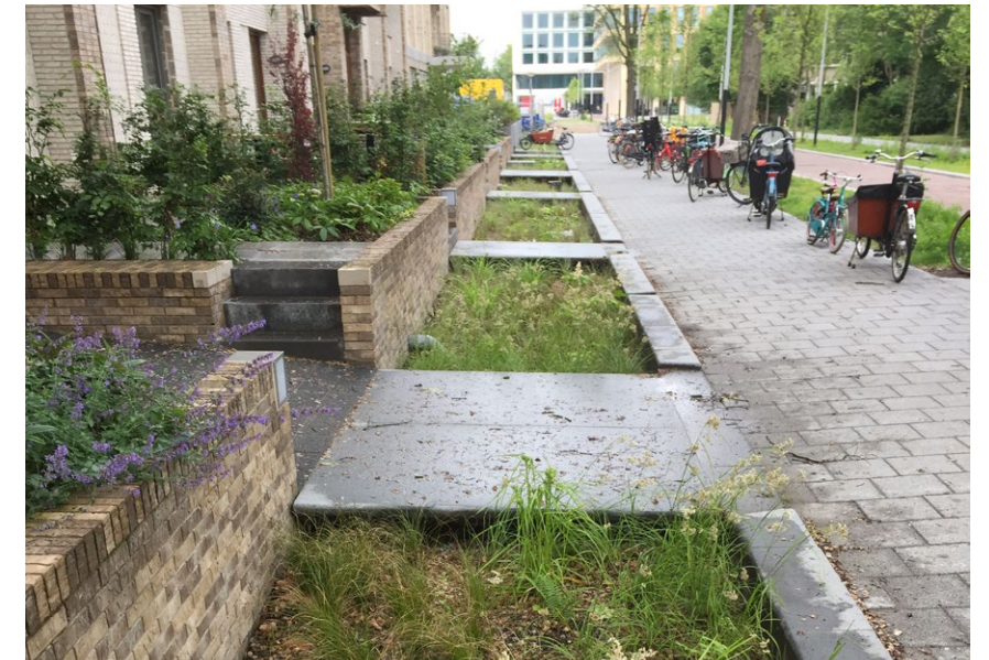
Figuur 33: Watervertragende voorziening draagt bij aan een klimaatadaptieve buurt en versterkt het straatbeeld
