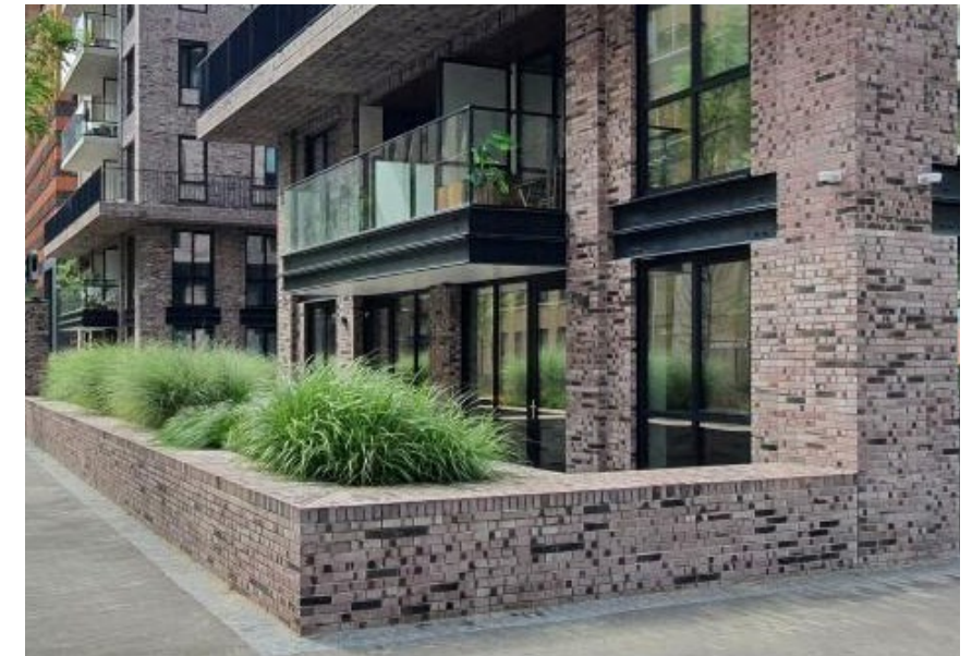
Figuur 38: Kleine private tuintjes aan de straatzijden worden meeontworpen met het gebouw, het metselwerk kan bijvoorbeeld doorlopen ter afbakening
