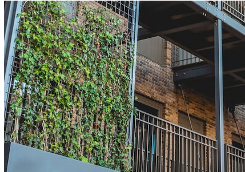
Figuur 35: Begroeiing (van stalen frames) zorgt voor een aantrekkelijk aanzicht en biedt privacy bij de balkons
