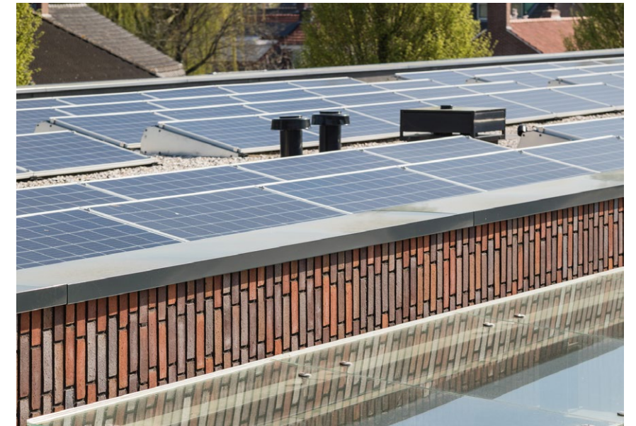
Figuur 53: Installaties zoals zonnepanelen op een kwalitatieve wijze als ingepast in de architectuur
