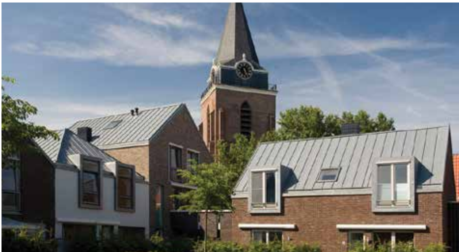
Kleinschalig waar nodig, zorgvuldige opbouw van volumes richting het centrum
