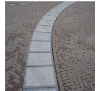
4. Gebakken verharding op het plein
