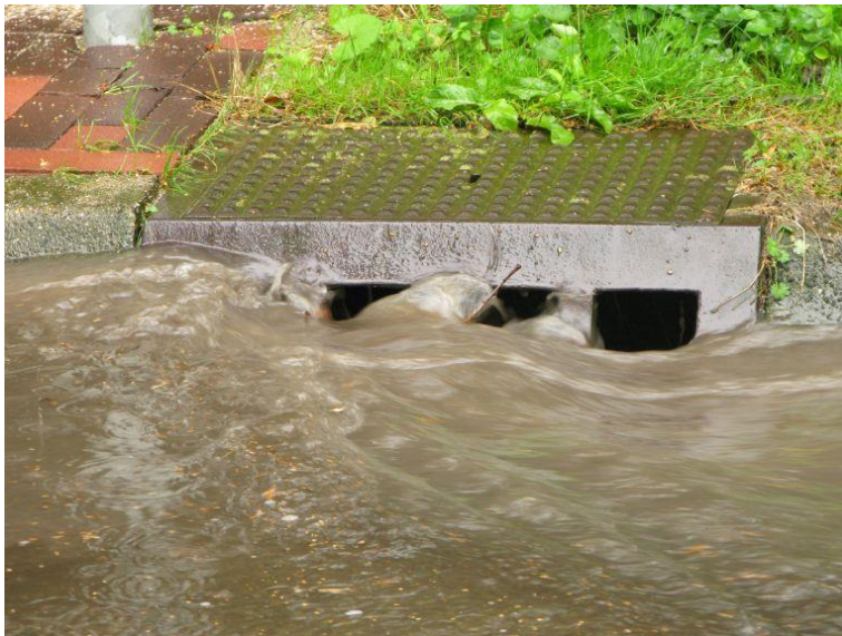
Afbeelding 6.3 overbelaste straatkolk (bron: GAW, stichting RIONED)
