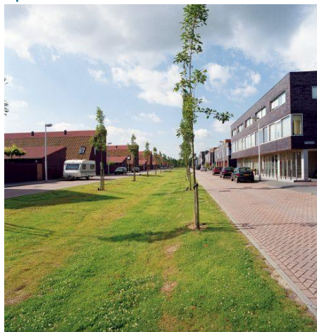
Afbeelding 6.1 WADI (bron: GAW, stichting RIONED)
