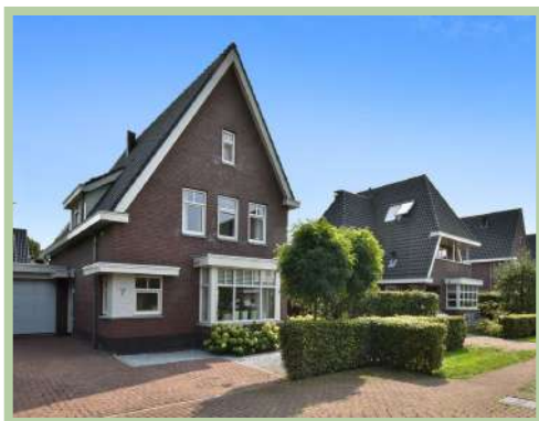
Kopgevels met overstek
