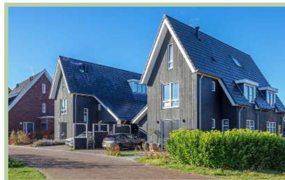
Gebakken klinkers als duurzame verharding
