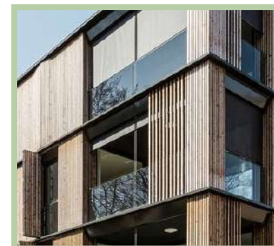
Diepte in de gevel
