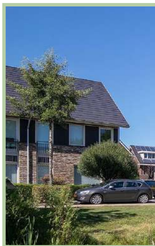
Langsgevel met overstek
