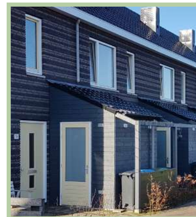
Berging onderdeel architectuur voorgevel
