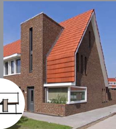
Verticaal element wat de goot doorbreekt.
