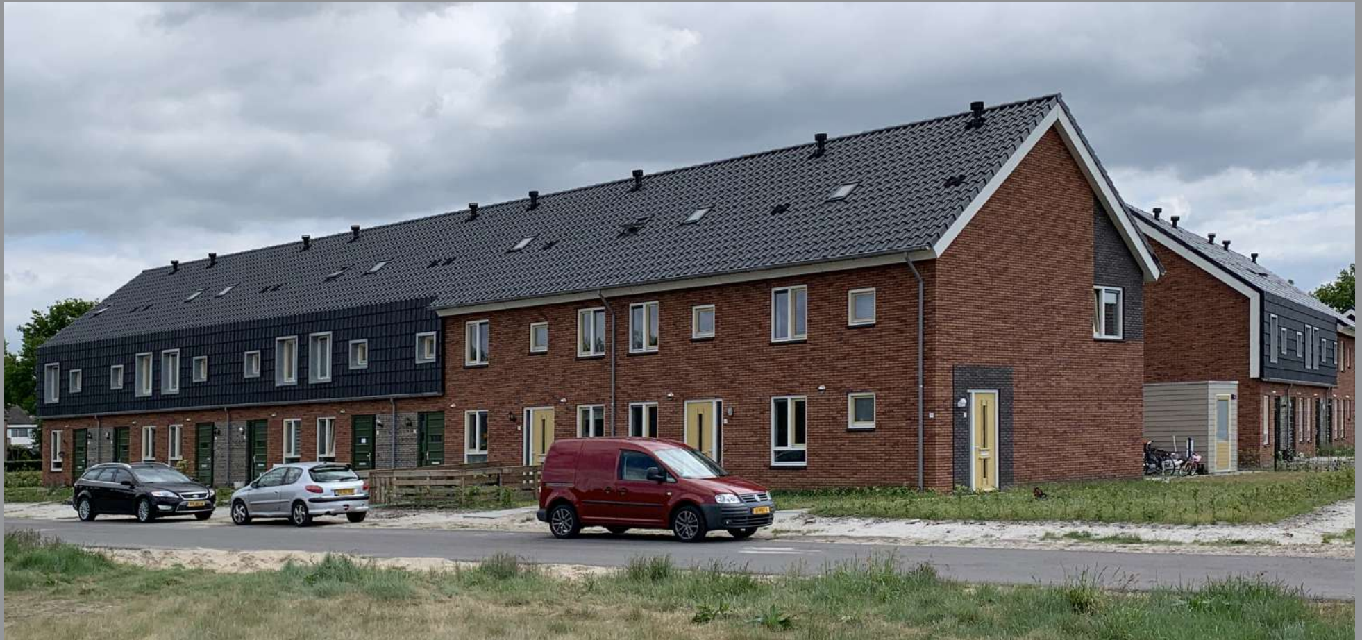
Een sterke verbijzondering waar een deel van de kap doorloopt in de gevel (2e fase Westerbouwlonden).
