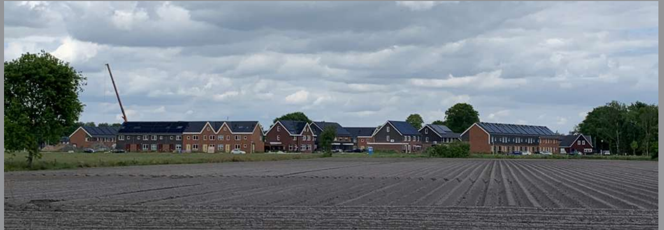
Zicht vanaf de Bouwhuisweg op deelgebied 1
