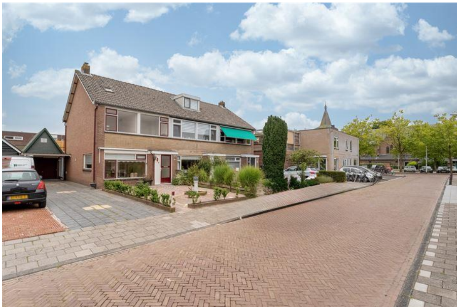
Figuur 5-13 Ter illustratie: rijwoningen aan de Koestraat met energielabel E uit 1969 3 .
