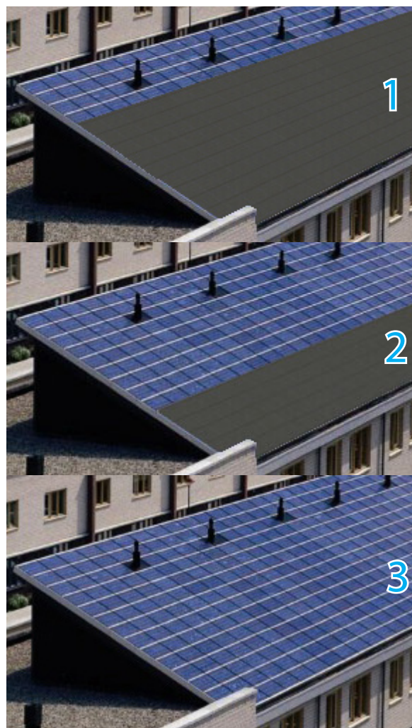
Het plaatsen van zonnepanelen in rijen, van boven naar onder.
