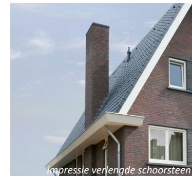
impressie verlengde schoorsteen
