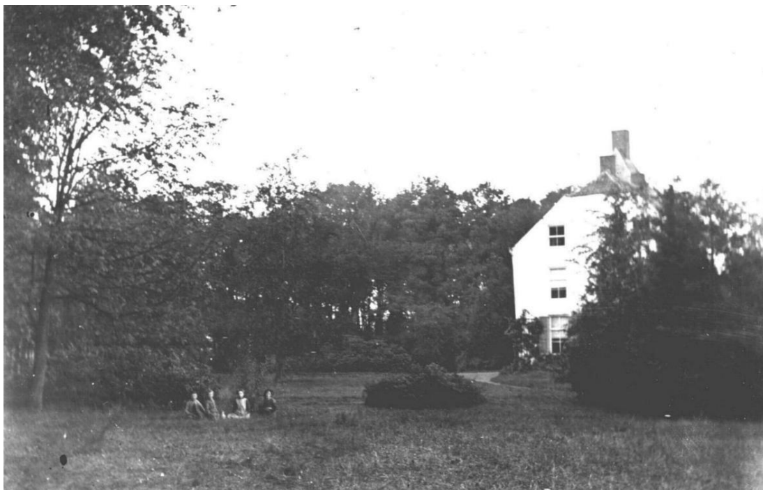
Figuur 58. Het park bij het Klein Kasteel, waarschijnlijk eind 19e eeuw. De zware schoorsteen op het dak van de woontoren was nog niet vervangen door de twee pironnen. Een identieke ingreep aan het Groot Kasteel werd in 1906-1908 gedaan; bij het Klein Kasteel zal het ook omstreeks die tijd gebeurd zijn (zie Keunen, 2019) (foto: Deurnewiki, collectie Oudheidkamer).
