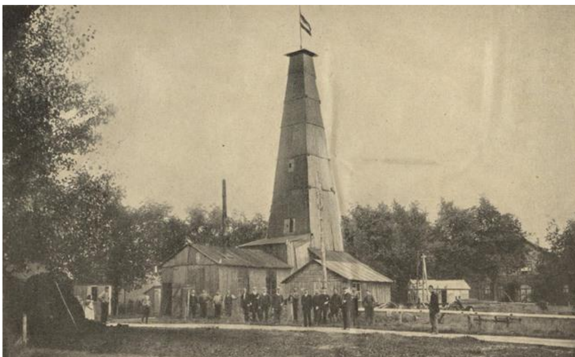
Figuur 146. De boortoren voor de proefboring in Helenaveen, 1906 (foto: Deurnewiki).
