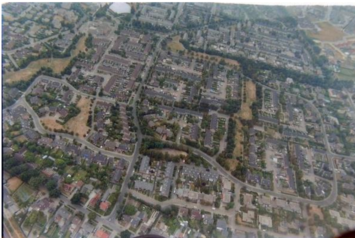
Figuur 229. Luchtfoto van de Koolhof in Deurne in 1990, met linksboven het wijkpark met geheel bovenaan nog de afgebroken Frans Hoebenshal, een markant en bijzonder gebouw. De foto is naar het noorden genomen, onderaan zien we nog de Hagelkruisweg en de spoorlijn (bron: Deurnewiki, collectie Kees Pijs).
