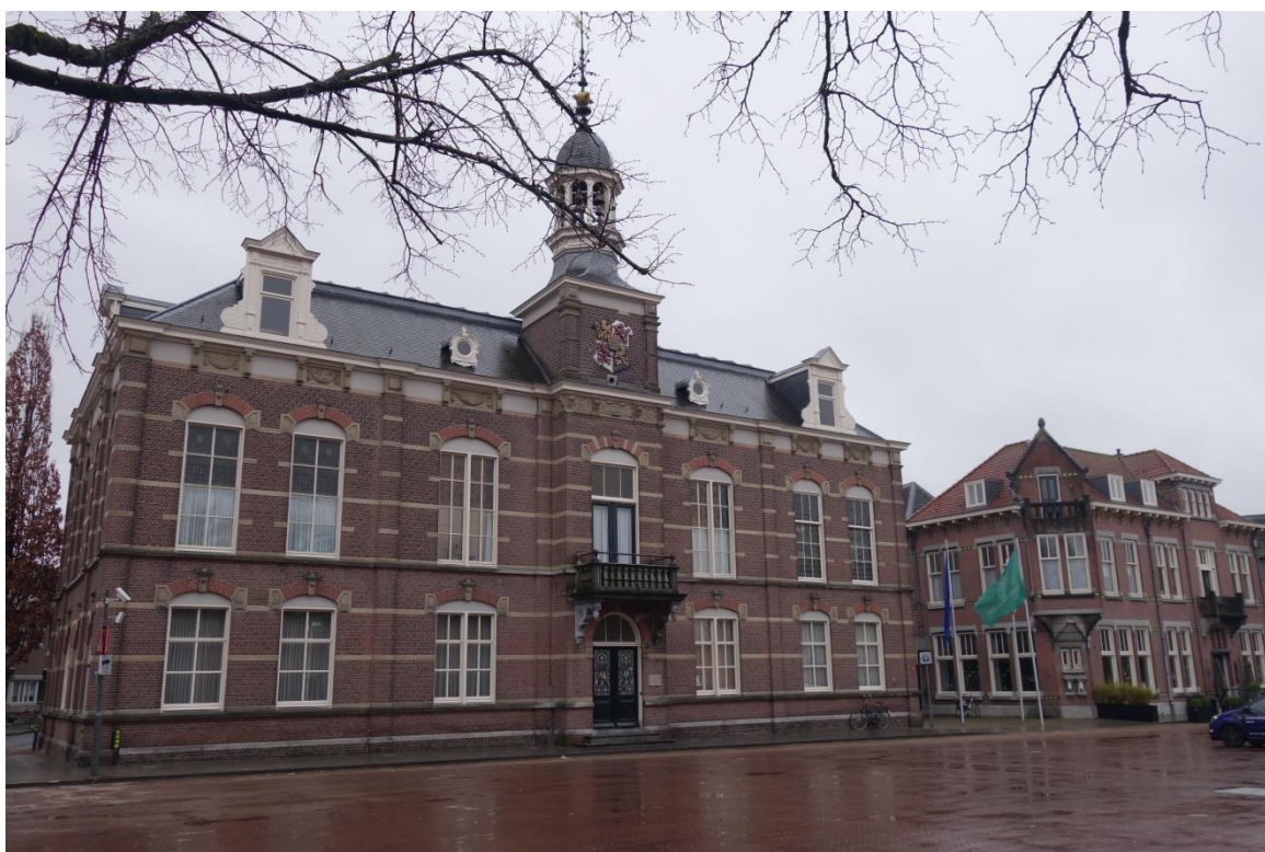
Figuur 167. Raadhuis en voormalig postkantoor bepalen de zuidwand van het centrale marktplein in Deurne (foto: MAB, 2020).
