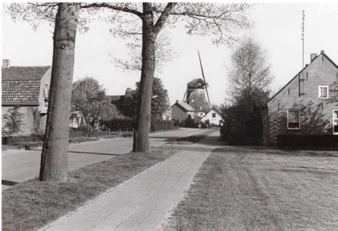
Figuur 144. De windmolen van Zeilberg tussen de bebouwing aan de Zeilbergsestraat (foto: Deurnewiki, collectie Harrie Biemans).
