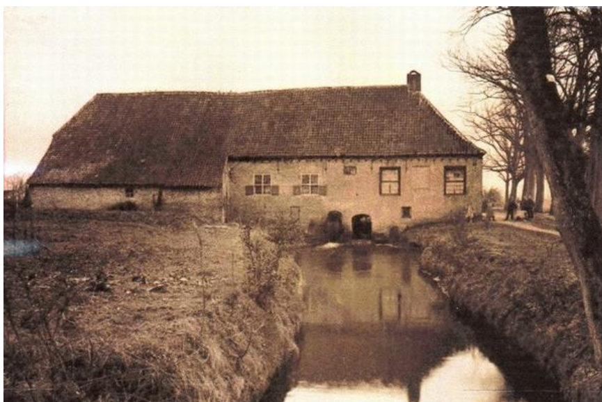
Figuur 142. De watermolen aan het Haageind vóór de sloop van het bedrijfsgedeelte (foto: Deurnewiki, collectie Frans Gloudemans).
