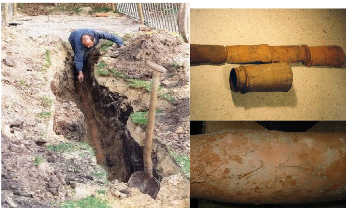
Figuur 22. Opgraving van de kannebuizen waterleiding bij de Hub van Doorneweg met rechts details van de genummerde waterleiding (bron: Deurnewiki).
