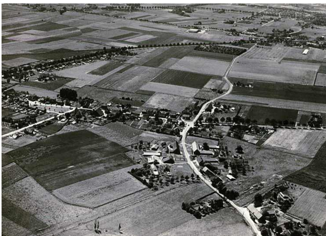
Figuur 40. Luchtfoto van de Deurnese Akker vanuit het noordoosten vóór de bouw van de wijk Koolhof. Van links naar rechts de Zeilbergsestraat, op de voorgrond de Kulertseweg en in het verlengde daarvan de Peelstraat. De gebogen weg met bomen op de achtergrond is de huidige Hagelkruisweg, achter het kruispunt van Peelstraat en Hagelkruisweg lag de oude hoeve Ter Eijnde in het gehucht Veldheuvel (foto: Deurnewiki/Frans Gloudemans).
