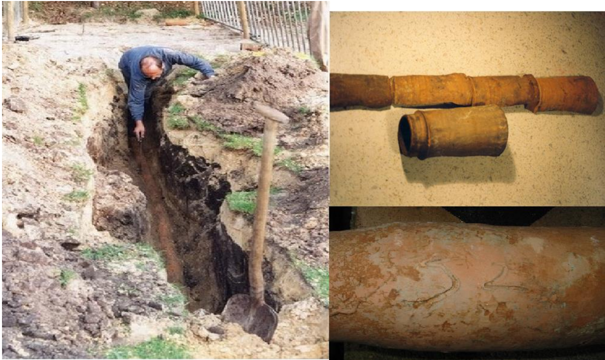
Figuur 199. Opgraving van de kannebuizen waterleiding bij de Hub van Doorneweg met rechts details van de genummerde waterleiding (bron: Deurnewiki).
