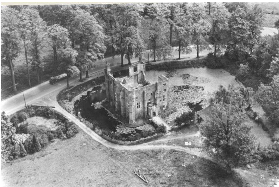
Figuur 201. Het Groot Kasteel na de verwoesting van 1944 en vóór de consolidatie van 1952. Aan het muurwerk is duidelijk te herkennen van welke zijden er is gevuurd. Op de voorgrond is één van de arkeltorens te herkennen. Een arkeltoren ontspruit als het ware op een hoger niveau op de gevel (foto: Deurnewiki, collectie Heemkundekring Deurne).
