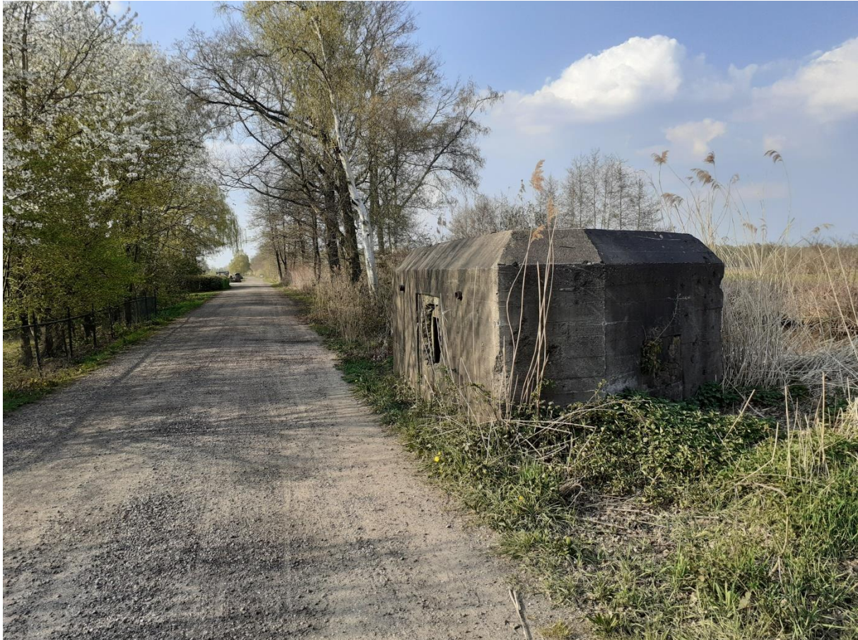
Figuur 27. De Peel-Raamstelling, met kazemat en rechts het Kanaal van Deurne (foto: RAAP, 8 april 2020).
