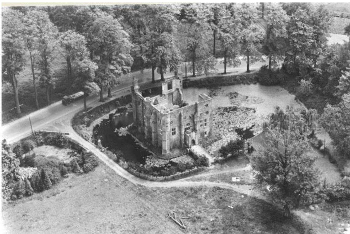
Figuur 24. Het Groot Kasteel na de verwoesting van 1944 en vóór de consolidatie van 1952. Aan het muurwerk is duidelijk te herkennen van welke zijden er is gevuurd. Op de voorgrond is één van de arkeltoeren te herkennen. Een arkeltoeren ontspruit als het ware op een hoger niveau op de gevel (foto: Deurnewiki, collectie Heemkundekring Deurne).
