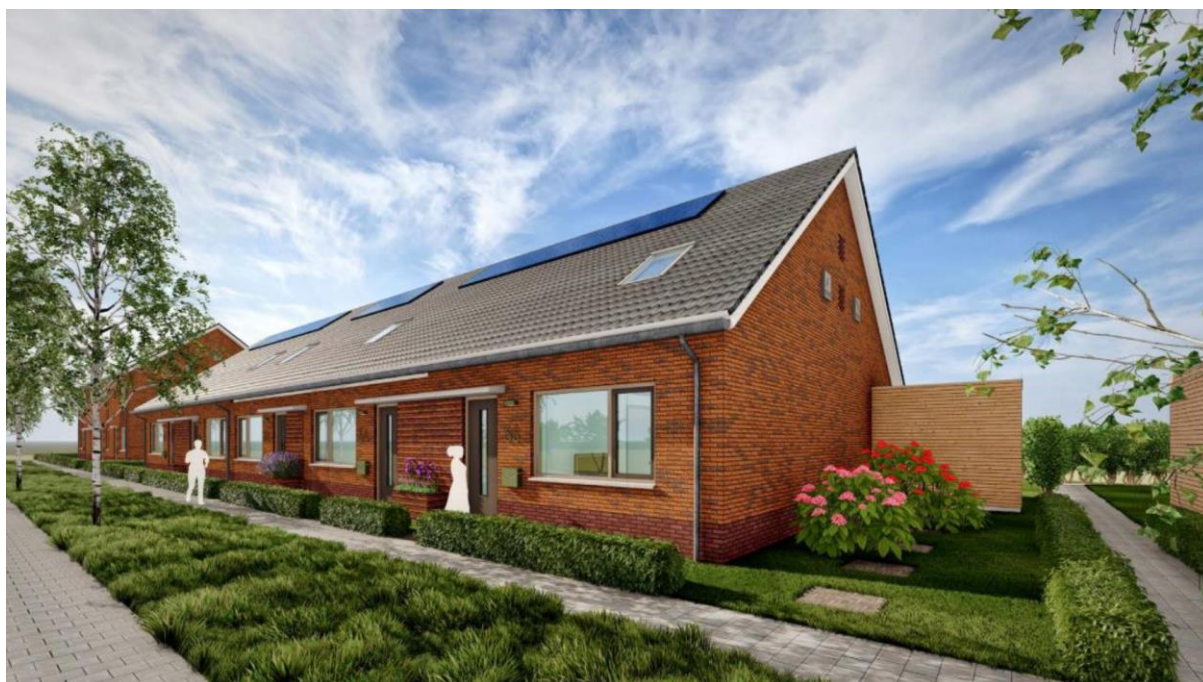
Impressie van de te bouwen Eengezinswoningen en levensloopbestendige woningen in de Bloemenbuurt (Project Flora23). De oorspronkelijke voortuinen worden ingericht als openbaar groen.
