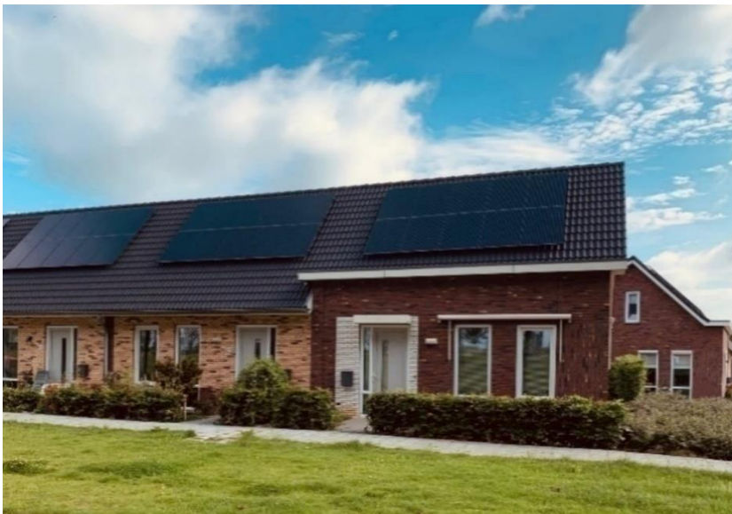
Levensloopbestendige woningen aan de Koppelweg (2020)
