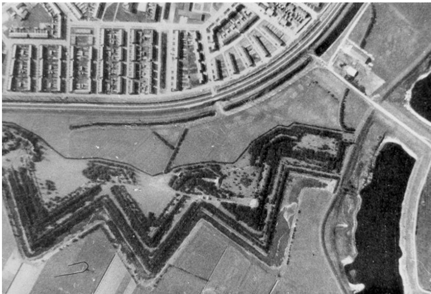
Deel van de Hoge Linie, luchtfoto van ca 1960 (Collectie Stichting Menno van Coehoorn)
