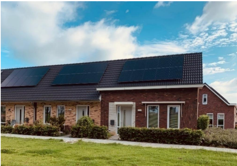
Levensloopbestendige woningen aan de Koppelweg (2020)
