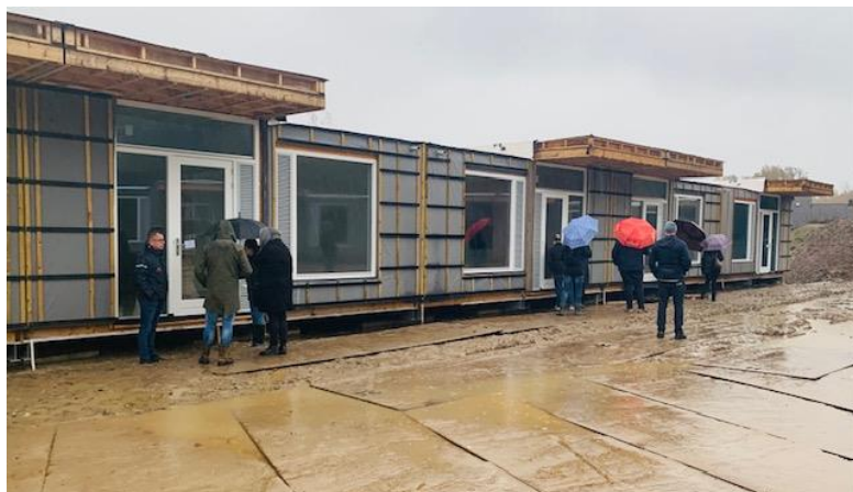
Flexwoningen in aanbouw (aan het begin van de Kraakselaan)
