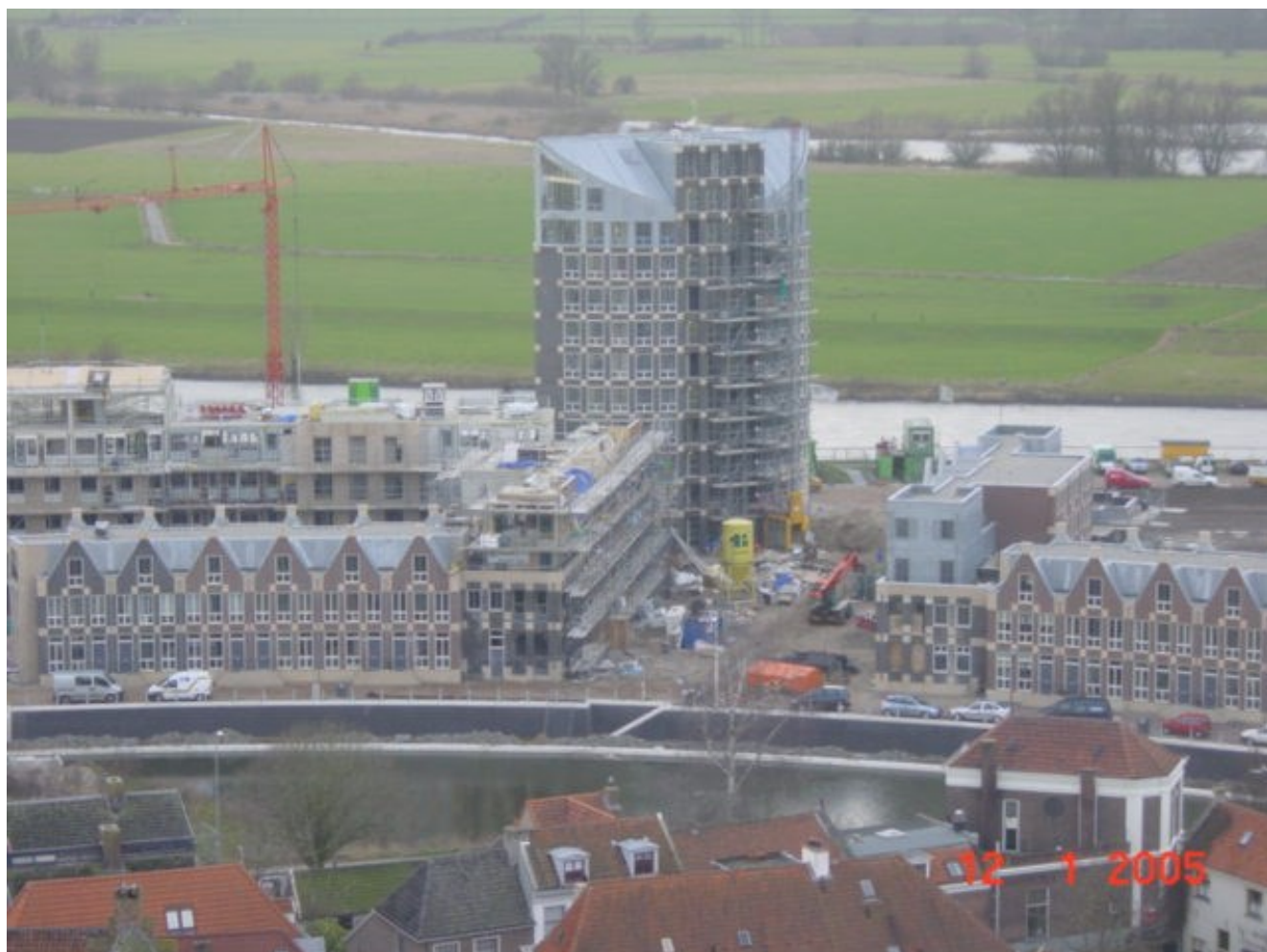
IJsselkade 1 e fase (in aanbouw)
