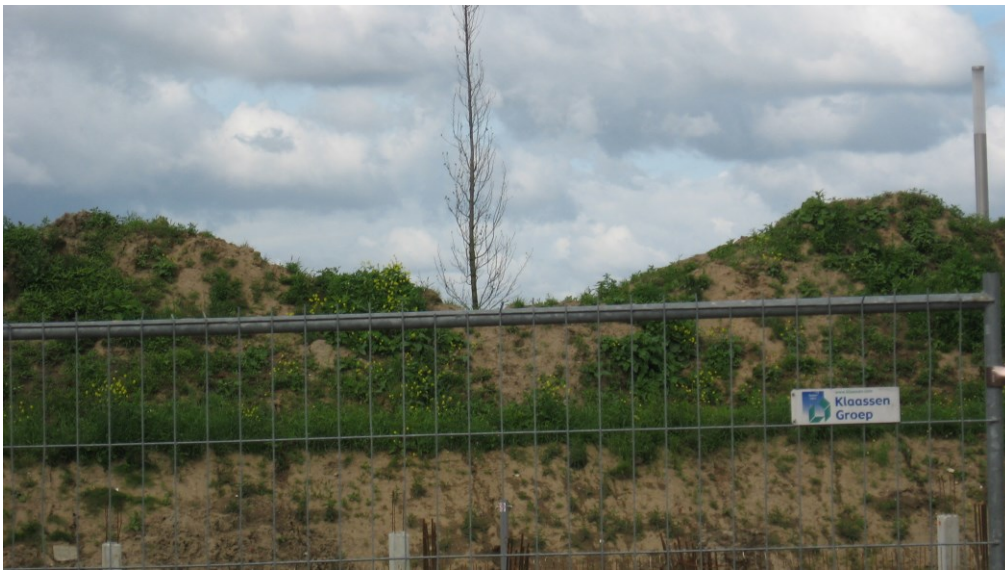
Bouwrijpmaken (locatie IJsselkade fase II)
