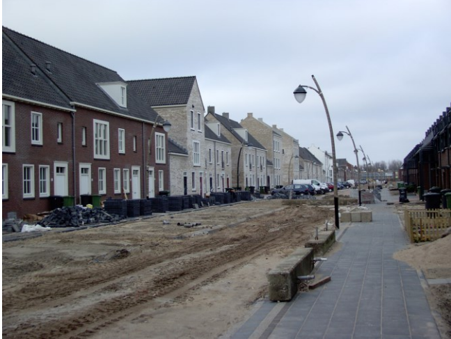
Het woonrijp maken van een recent opgeleverde woonwijk.....
