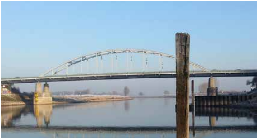
IJsselbrug bij Doesburg: Alexander Ver Huellbrug
