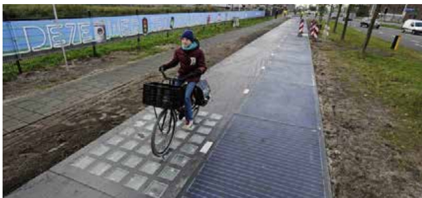
Fietspad met zonnepanelen (Krommenie)
