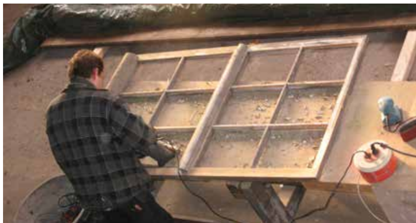
Een vakman is bezig met de restauratie van de ramen van de Exercitieloods.
