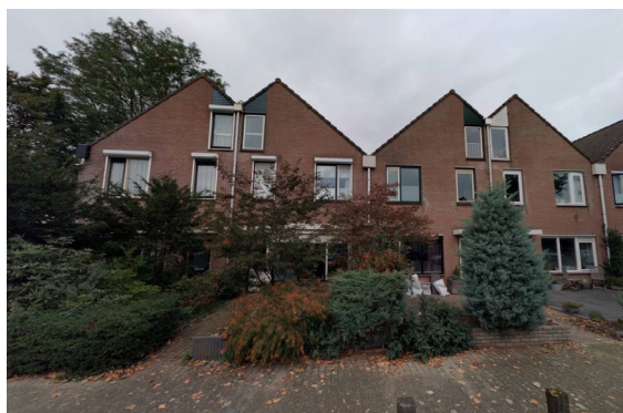
Bingerdensedweg, rijtjeswoningen met topgevels
