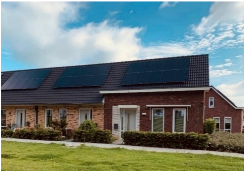
Levensloopbestendige woningen aan de Koppelweg (2020)
