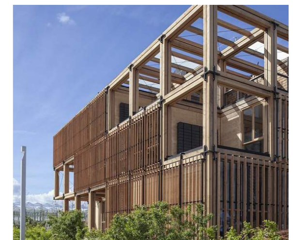
Modulair wooncollectief met deelvoorzieningen
