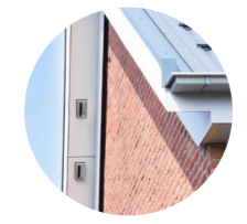
Vleermuiskast in gevels
