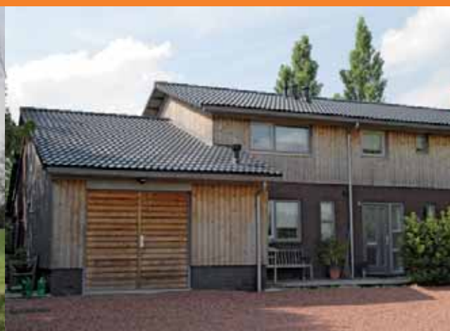
Naar voren stekende uitbouw bij rijwoning
