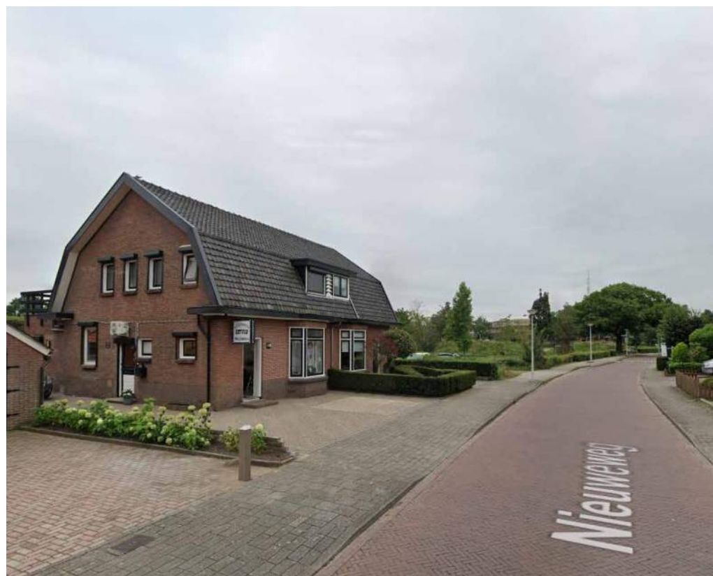
de Nieuweweg (bron: Google Streetview)
