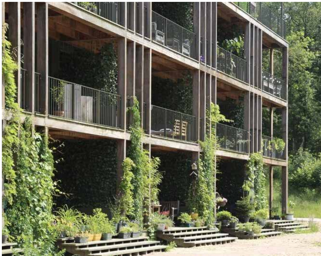
gevelbegroeiing (bron: MIX architectuur)
