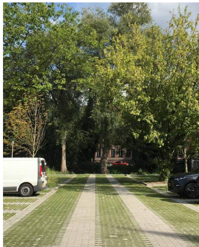
karrenspoor in grasbetonstenen (bron: Struyk Verwo Infra)
