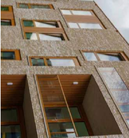
Houten elementen zoals vlakken, shutters en lamellen verbinden de gevel.
