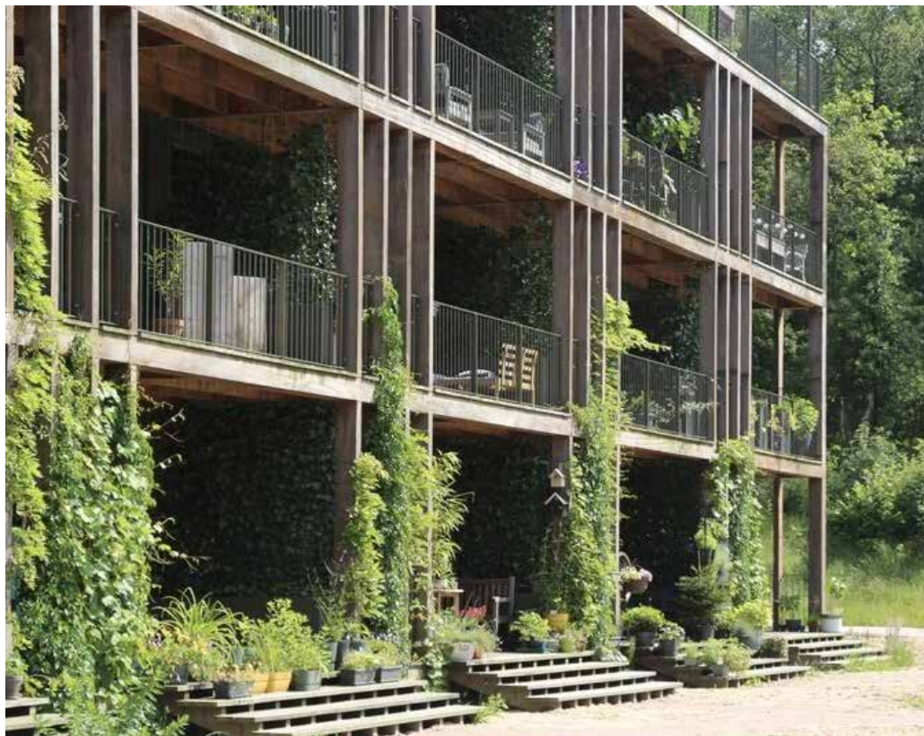
gevelbegroeiing (bron: MIX architectuur)
