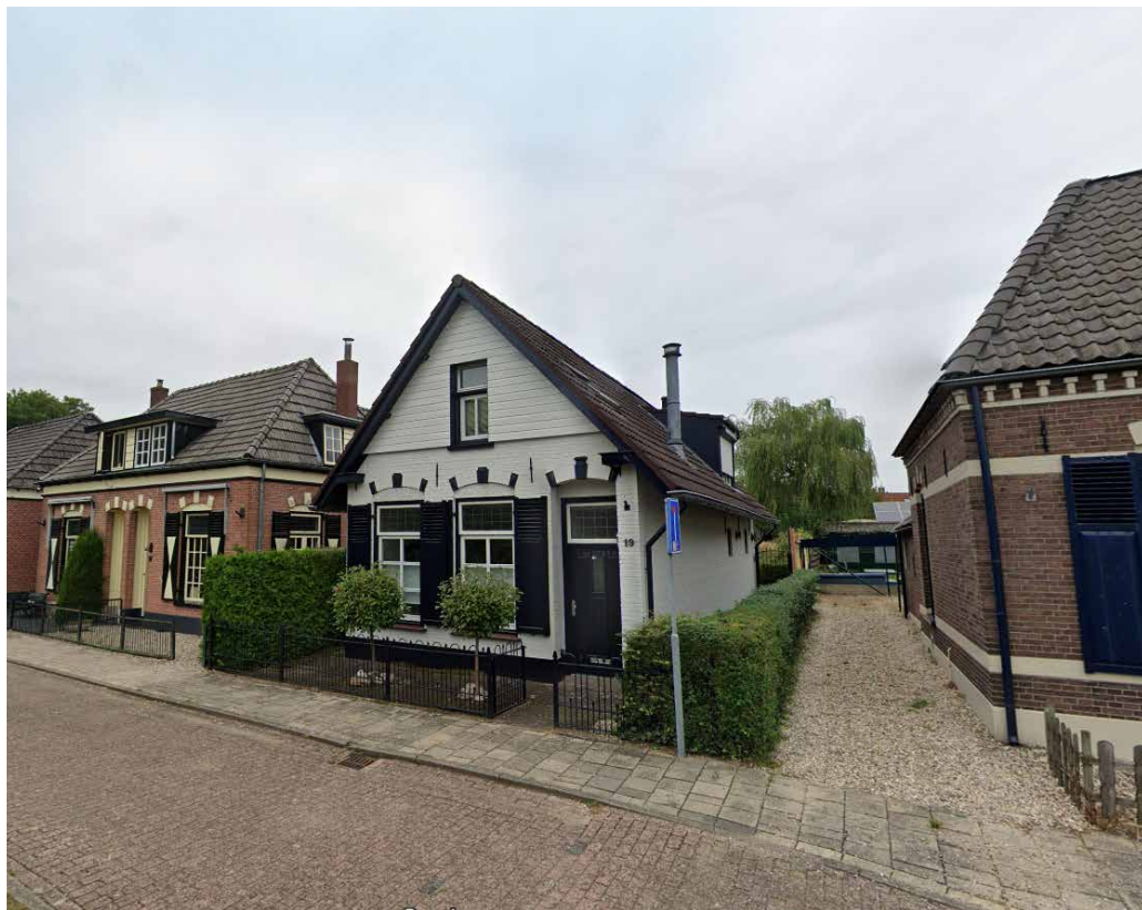
de Nieuweweg (bron: Google Streetview)
