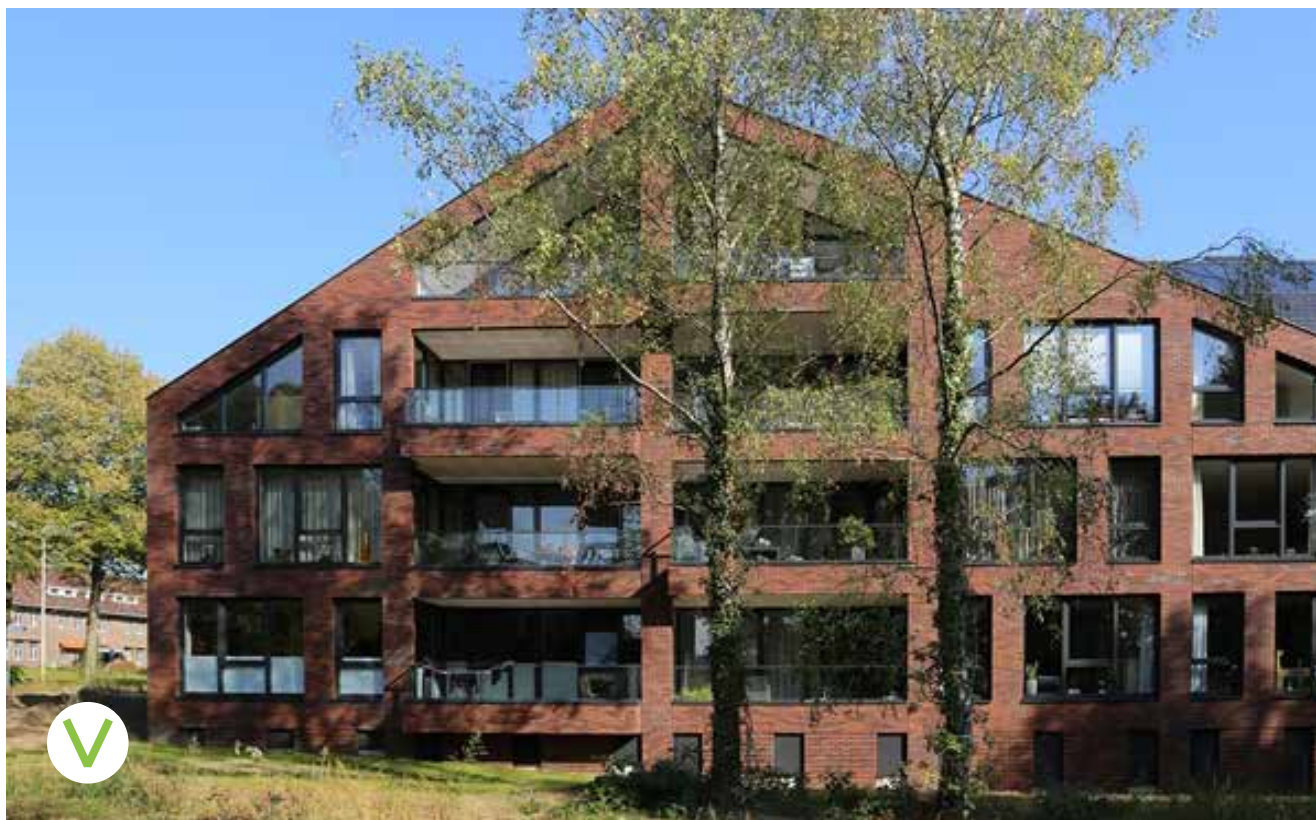
de balkons zijn ondergeschikt aan het hoofdvolume (bron: MIX architectuur)
