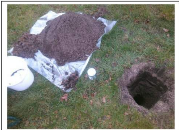
Foto 13. Opgegraven en gezeefd materiaal inspectiegat C10
