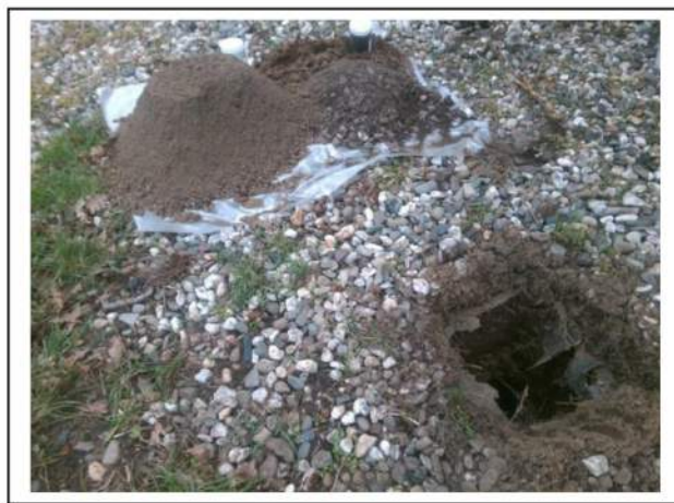
Foto 6. Opgegraven en gezeefd materiaal inspectiegat C02
