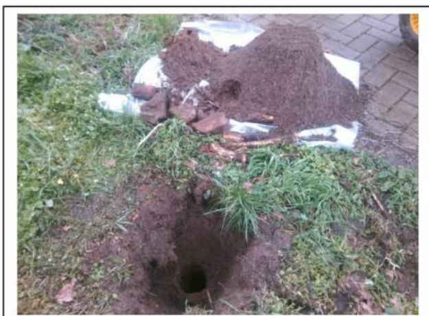
Foto 15. Opgegraven en gezeefd materiaal inspectiegat C12
