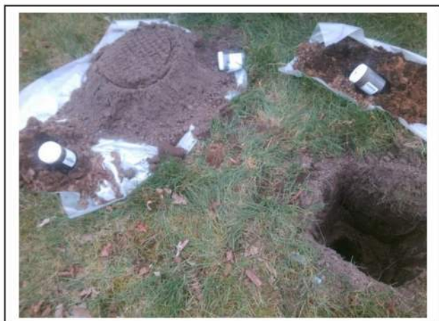
Foto 5. Opgegraven en gezeefd materiaal inspectiegat C01
