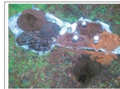
Foto 16. Opgegraven en gezeefd materiaal inspectiegat C13
