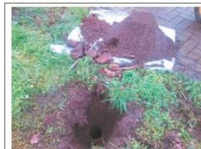
Foto 15. Opgegraven en gezeefd materiaal inspectiegat C12
