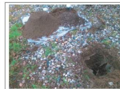
Foto 6. Opgegraven en gezeefd materiaal inspectiegat C02
