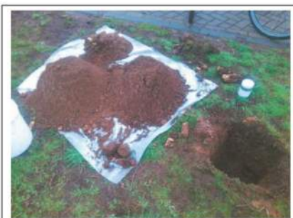
Foto 11. Opgegraven en gezeefd materiaal inspectiegat C08
