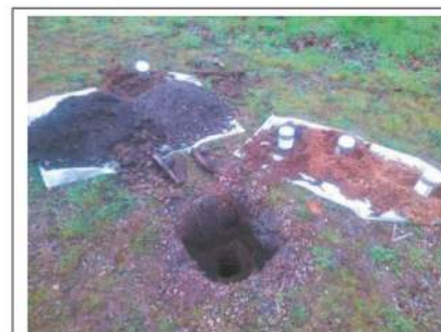
Foto 3. Opgegraven en gezeefd materiaal inspectiegat B03
