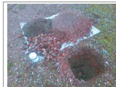
Foto 1. Opgegraven en gezeefd materiaal inspectiegat B01
