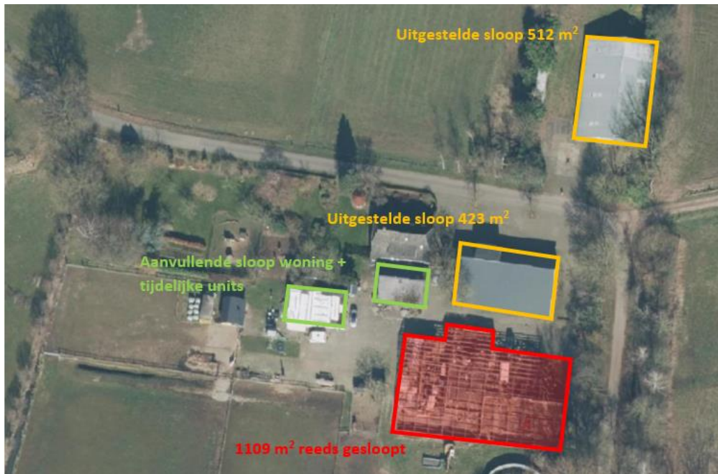
Figuur 8. Overzicht te slopen en reeds gesloopte opstallen.
