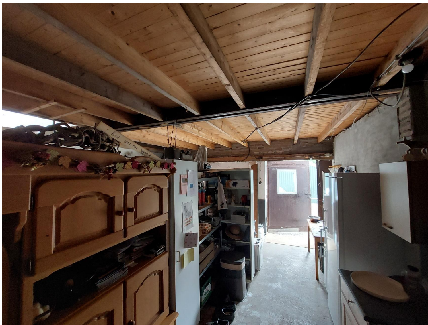
Figuur 5. Zicht vanuit de schuur naar buiten, situatie op 16 augustus 2023.
