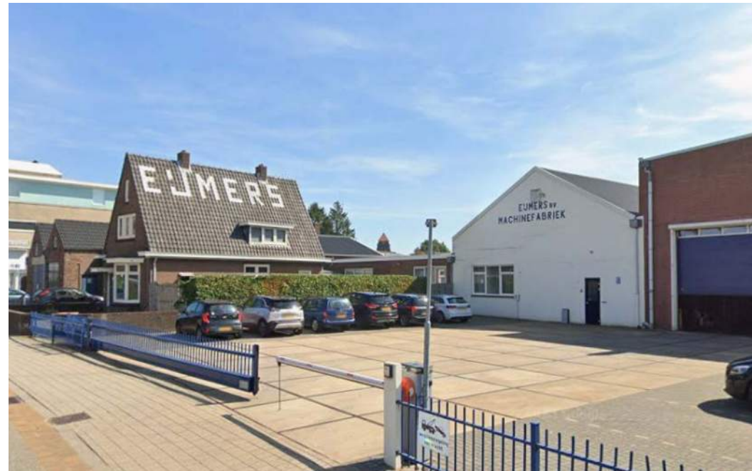
Het fabriekscomplex met woning en bijbehorende werkplaatsen.
