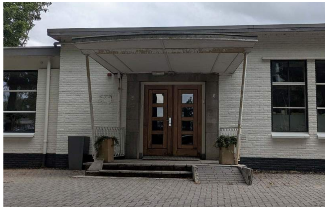
De markante entreepartij van het fabrieksgebouw.
