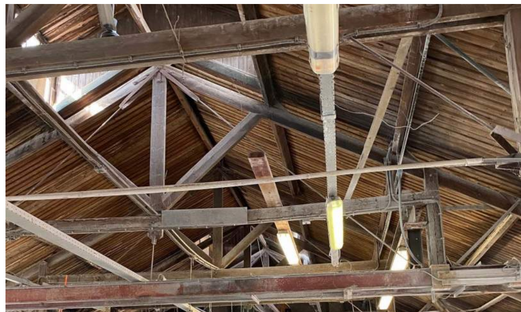
De dakconstructie van de steenhouwerswerkplaats in 2025.
