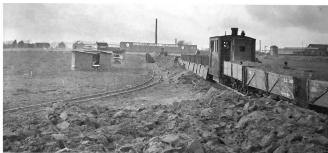
De ophooging van het Hamburgerbroek over een oppervlakte van 9 H.A. is met ruim 80 werklozen der gemeente Doetinchem, onder leiding van den Heer Roos, hoofdopz. der Ned. Heide Mij., ter hand genomen. Per G. T. M. wordt het benodigde zand vanaf de Gaanderensche bulten naar het terrein vervoerd. Op den achtergrond de rubberfabriek „Vredestein”
