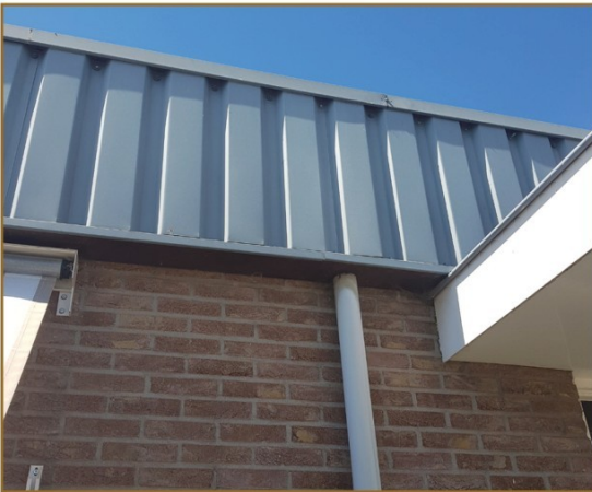
Afbeelding 5: In de bebouwing zijn geen openingen aanwezig.
