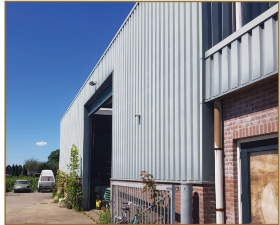
Afbeelding 4: Gladde, metalen gevelbeplating.
