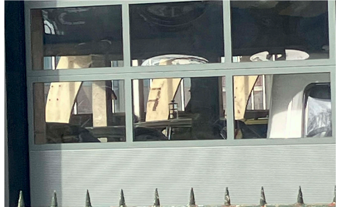
Details van de constructie in de kleinere hal.
