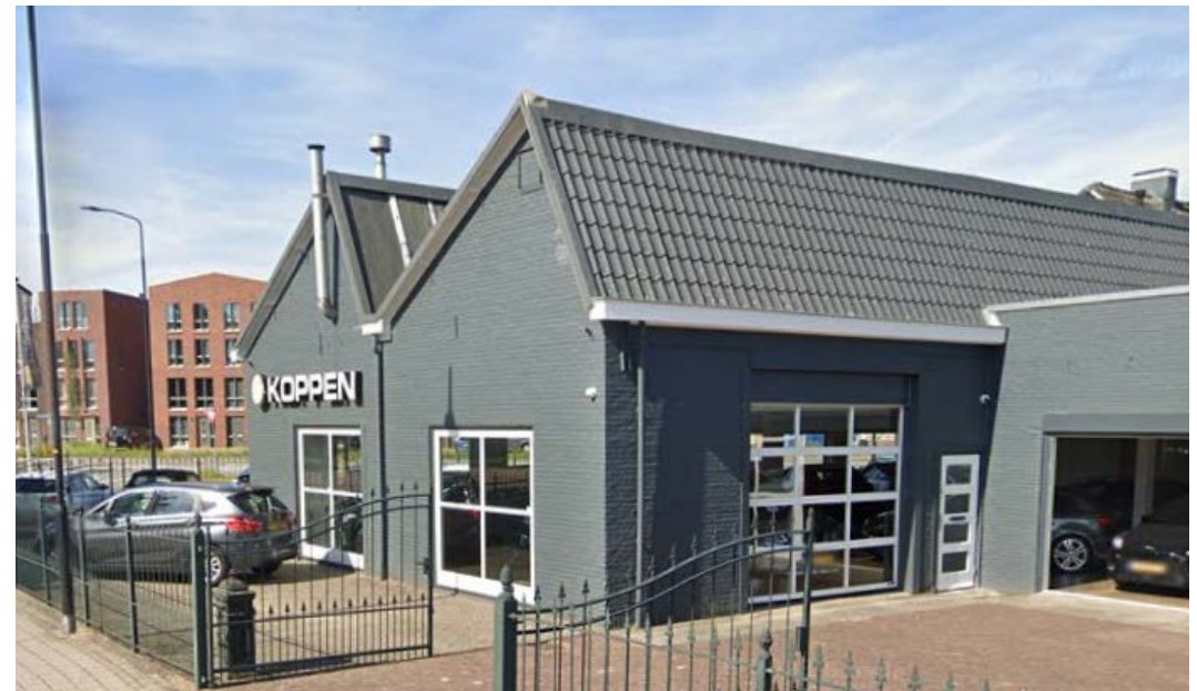
De sheddaken zijn nog steeds goed zichtbaar.
