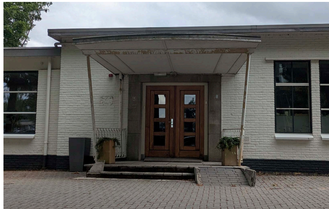
De markante entreepartij van het fabrieksgebouw.
