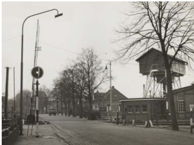
Spoorwegovergang Terborgseweg richting zuiden, jaren '50.
