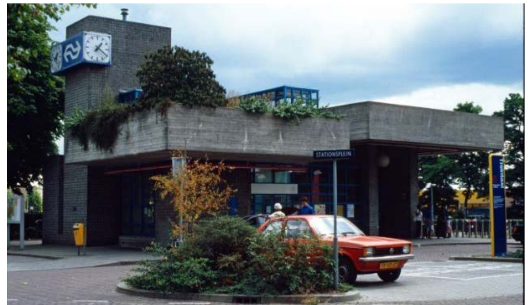
Station Doetinchem 1995, met overkragende begroeiing op het dak.
