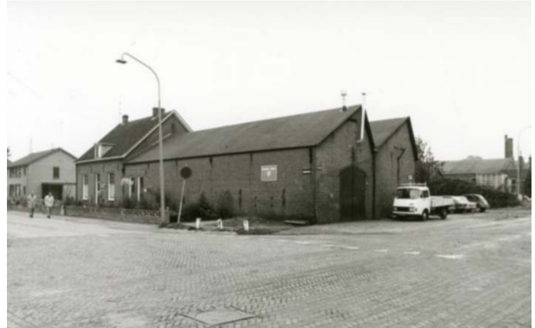
De oude constructiewerkplaatsen in 1975.
