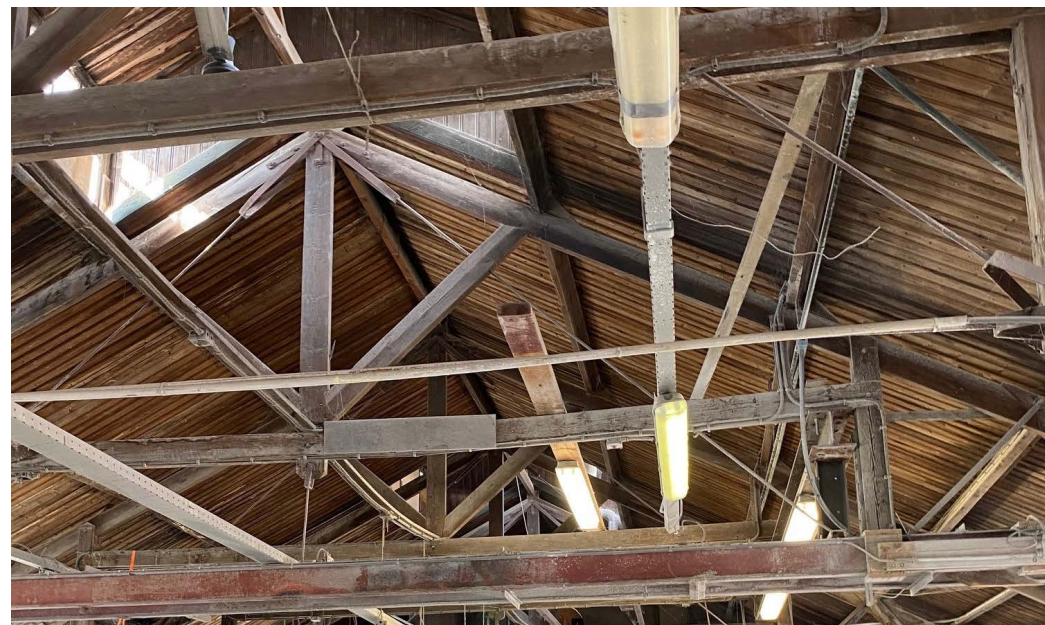
De dakconstructie van de steenhouwerswerkplaats in 2025.
