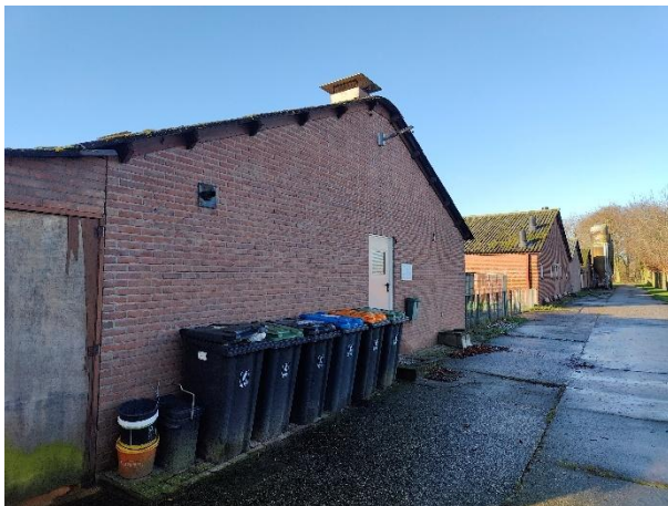
Impressie van de op het erf aanwezige bebouwing.
