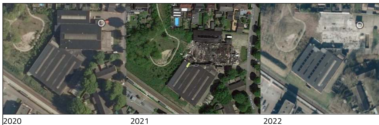
Figuur 2.3: Luchtfoto's van de locatie voor de brand, kort na de brand en na opruimen (Bron: Google Maps)
