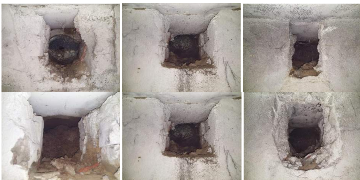
Figuur 5.6 & 5.11: Gaten in de kelder wand
