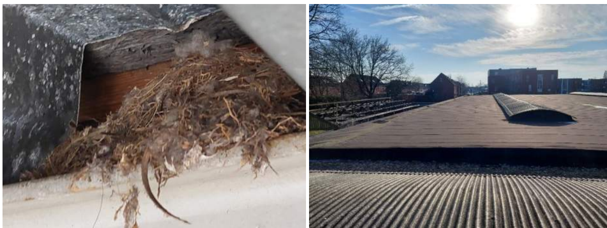
Figuur 5.12 & 5.13: Nest tegen het dak binnen in de loods en boven aanzicht van het dak
