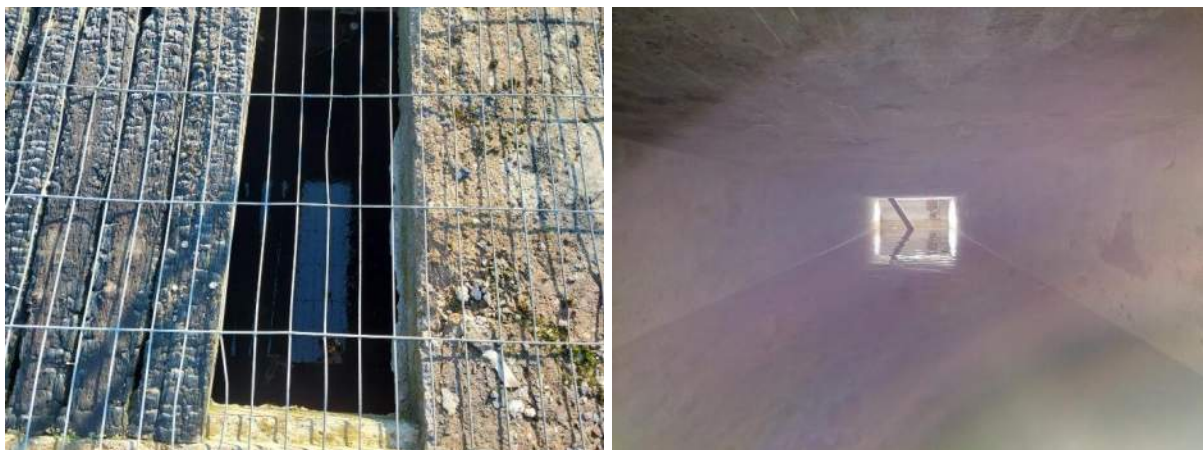
Figuur 5.4 & 5.5: ingang tot kelder en overzichtsfoto van de kelder
