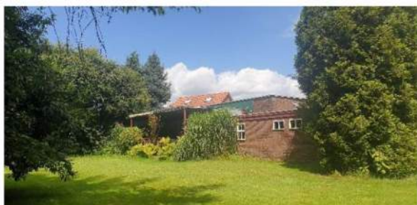
Foto 5: Deel tuin met achterzijde aanbouw dansschool
