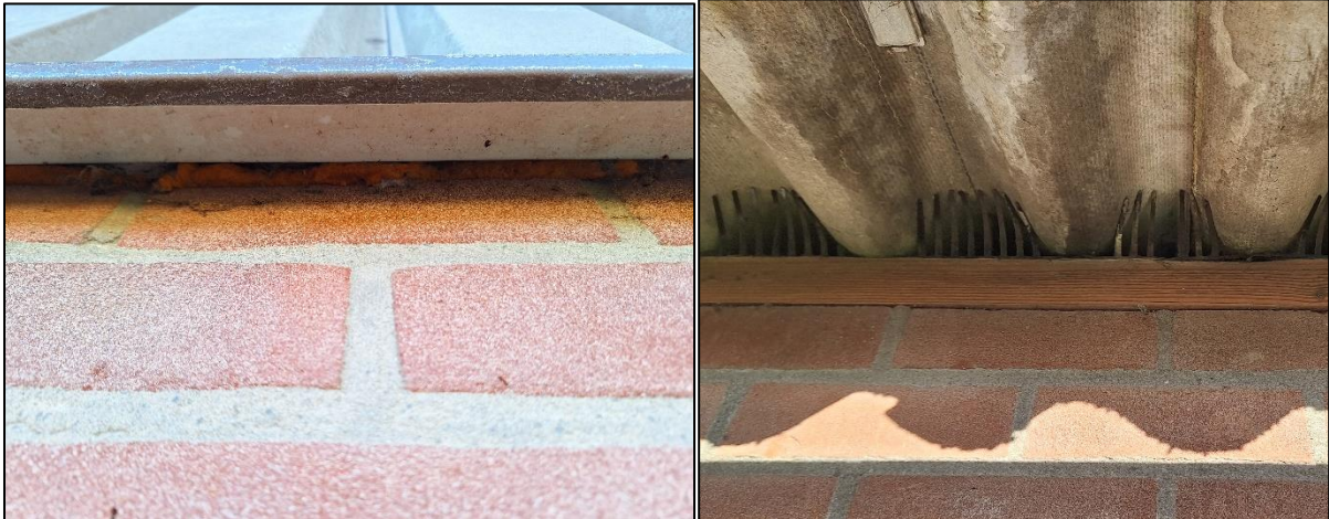
Foto links: de ruimte tussen de buitengevel en gevelbekleding kiert maar is niet toegankelijk voor vleermuizen. Foto rechts: faunarasters onder de golfplaten van de varkensschuren.
