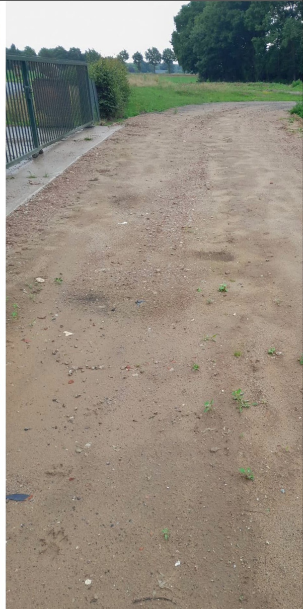
FOTO 9 MENGRANULAAT VERHARDING (RICHTING ZUIDEN)
