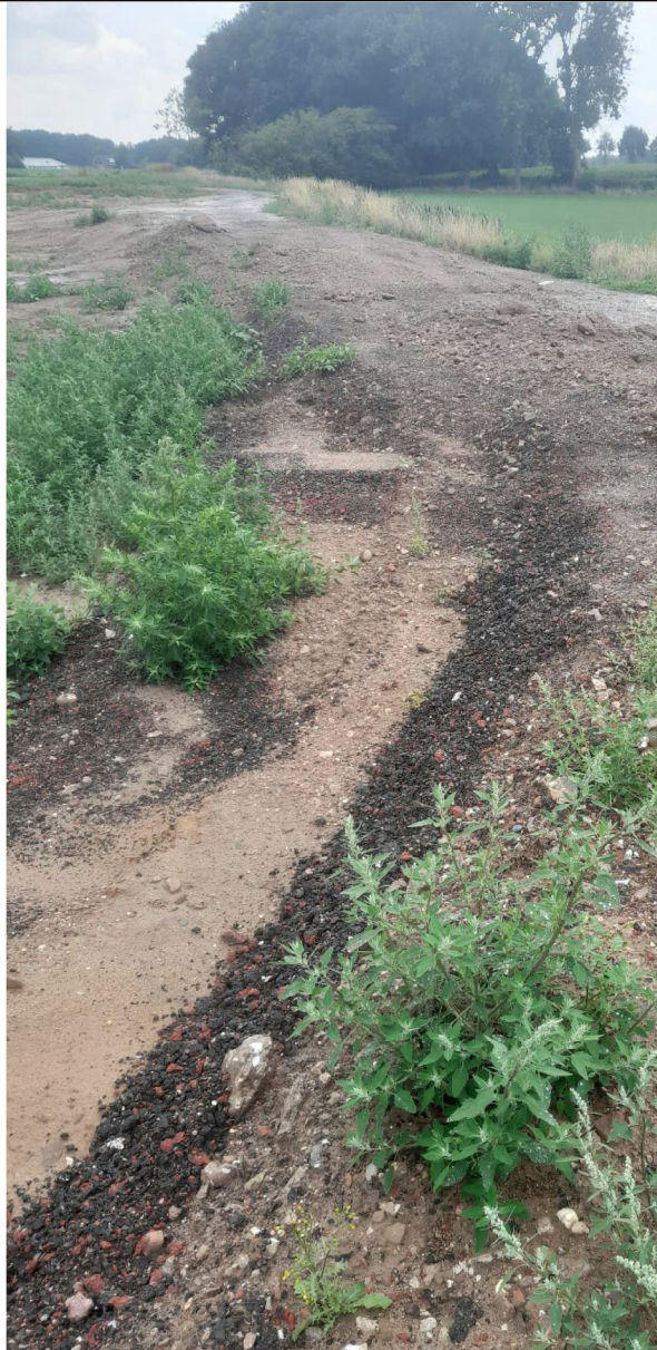
FOTO 8 MENGRANULAAT VERHARDING (RICHTING NOORDEN)
