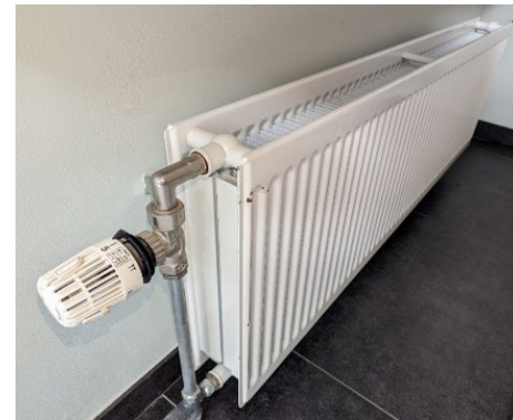
Figuur 16 een 'gewone' radiator die past bij de temperatuur van een cv-ketel op aardgas
