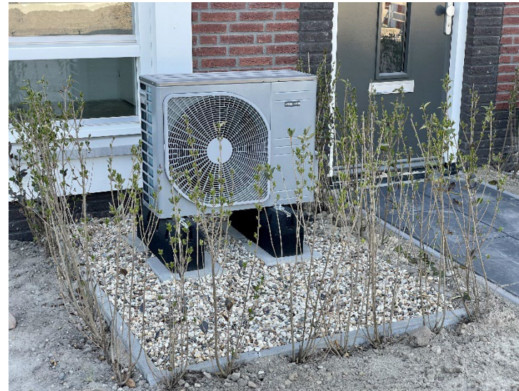
Figuur 17 Buitenunit van een lucht-water warmtepomp
