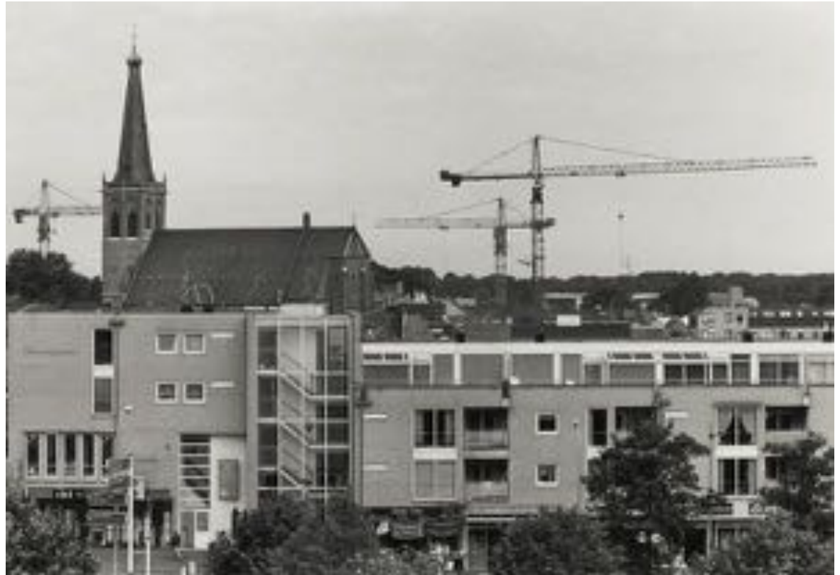
Moderne winkel- en kantoorpanden uit ca. 1990 aan de Raadhuisstraat, een voorbeeld van relatief recente stadsvernieuwing aan de rand van het centrum. De foto is in 1998 genomen vanaf het gemeentehuis, in de binnenstad staan drie grote hijskranen.
