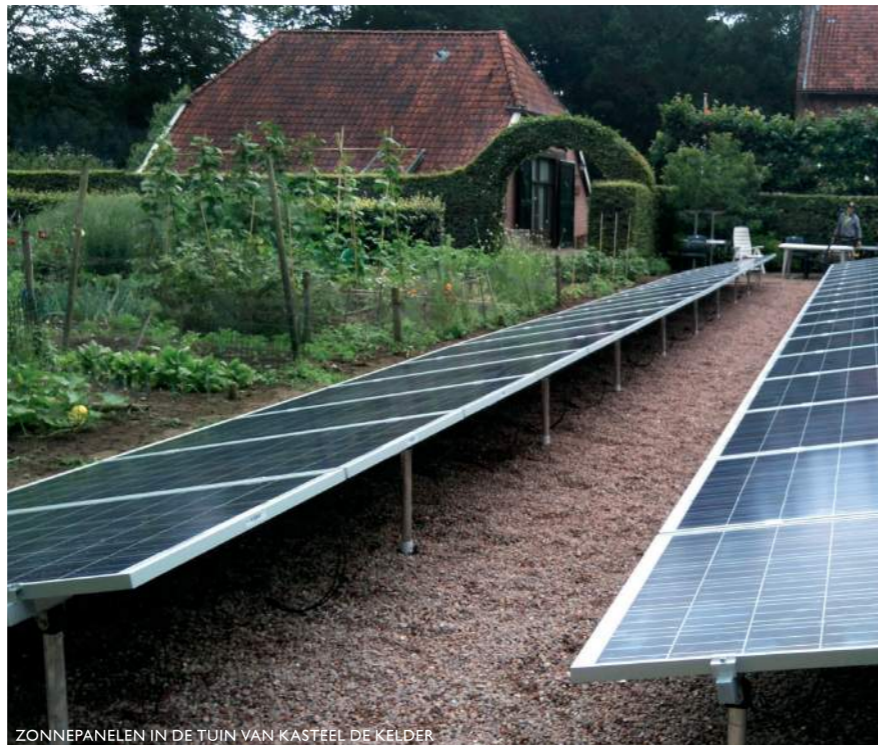
ZONNEPANELEN IN DE TUIN VAN KASTEEL DE KELDER
