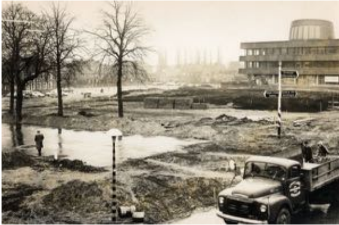
Zicht op de aanleg van het kruispunt aan de Terborgseweg in 1968. De historische structuur is destijds volledig verdwenen voor de aanleg van de Raadhuisstraat en de bouw van een nieuw gemeentehuis.
