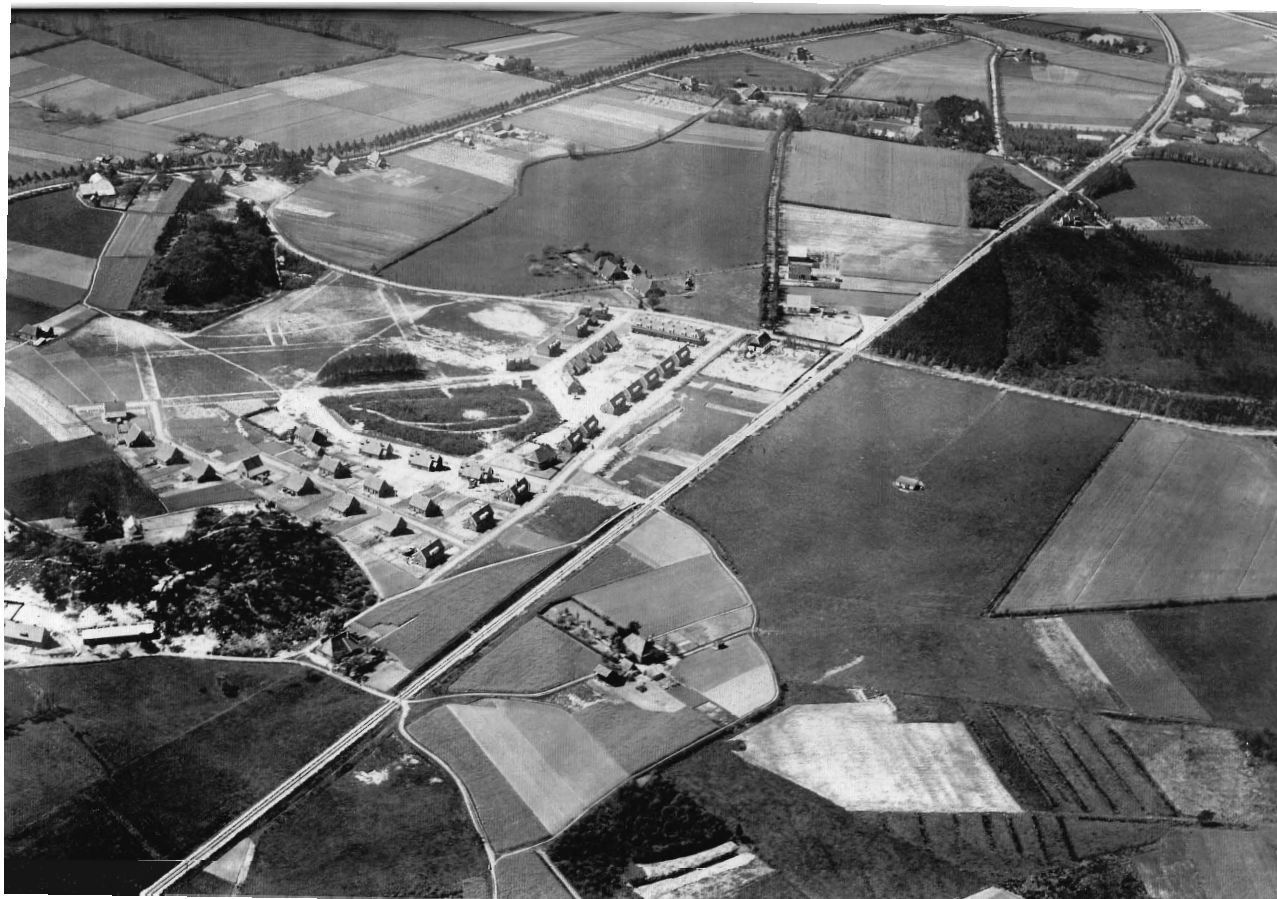
Luchtfoto uit 1929 van de buurt De Linzebosch in de wijk Oosseld in aanbouw tussen de (Oude) Terborgseweg en de spoorlijn. Er staan reeds woningen aan de Asterstraat en omgeving. Ook de tracé's van de Acacialaan en de Lijsterbeslaan zijn te herkennen. Hier zou in de jaren '30 het Vijverbergkwartier verrijzen. Daar waar de Lijsterbeslaan het spoor overgaat ligt een vijver met links daarvan het voormalige Hotel De Vijverberg. Aan de rechterkant van het spoor ligt nu het Graafschapstadion.
