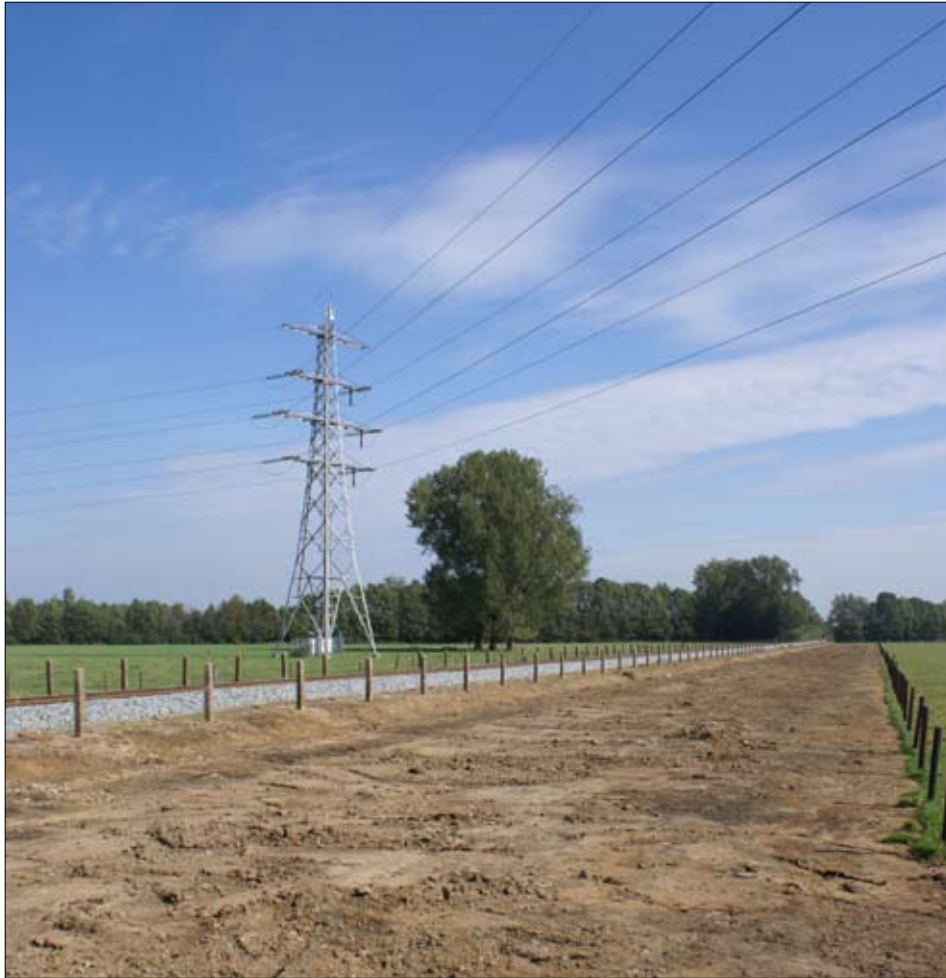
Een hoogspanningsmast ter hoogte van de spoorlijn die het gebied doorkruist.
